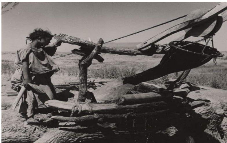
fig.2 Puits de type ancien, ughrur à Taous, dans le Tafilalet. L'eau remontée dans une outre par traction animale ou humaine est déversée dans la séguia d'irrigation 1950.
